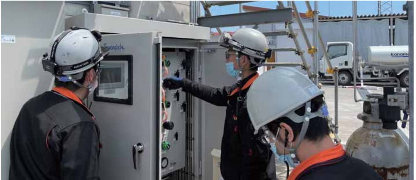
ガス供給制御盤 画像提供：インターステラテクノロジズ株式会社
